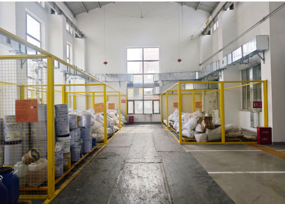
○ 电机公司新建危废库房并投入使用
